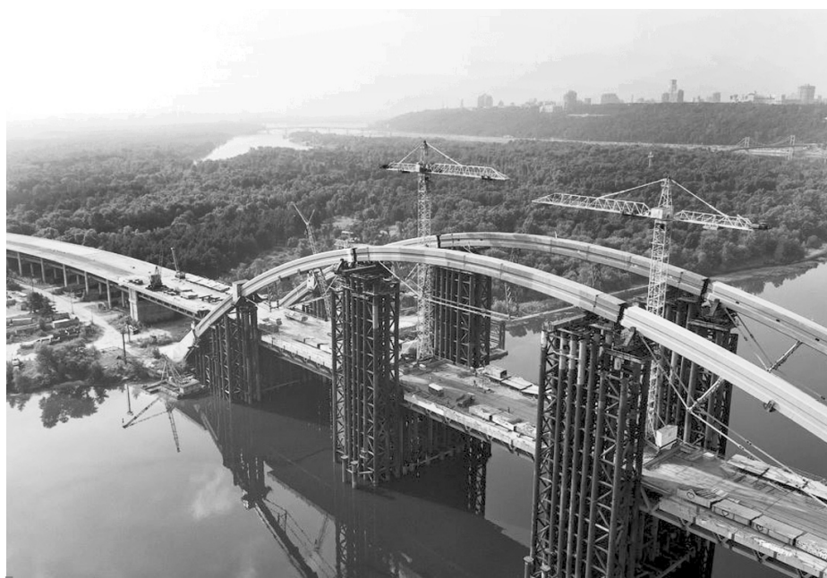
Міст, якого зачекався Київ. Фото з сайта 5.ua.
