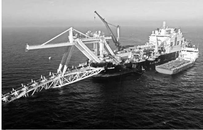
Будівництво газопроводу поновили в грудні 2020-го.
