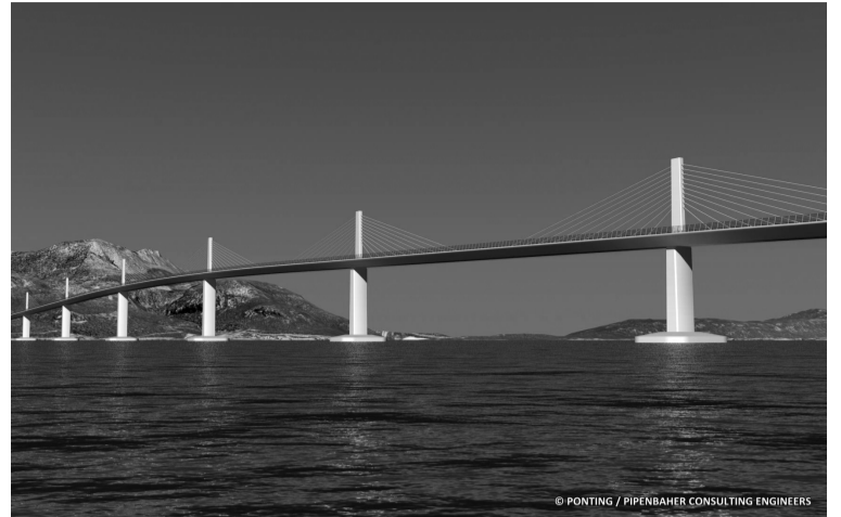
Цей вантовий міст має довжину 2 тис. 404 метри та ширину 23,6 метра. Його висота — 55 м, щоб кораблі могли проходити під ним до порту Неум.
