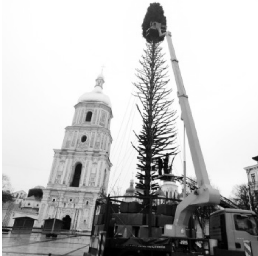
Монтаж новорічної казки.
