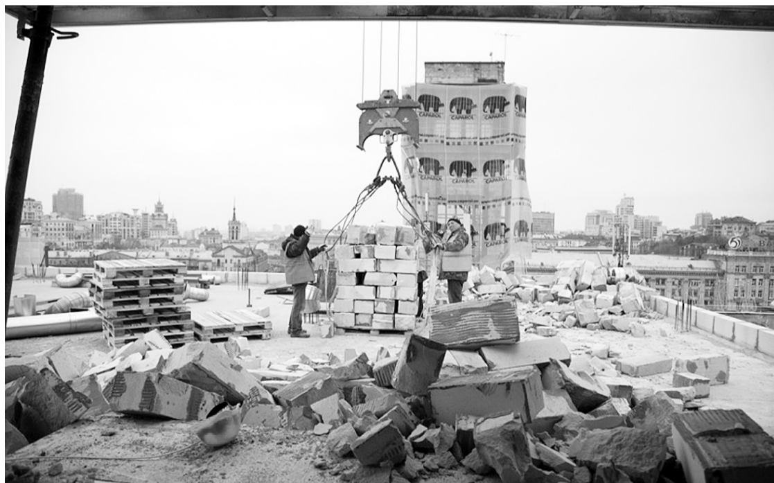
Демонтаж незаконної надбудови розпочали. Чи закінчать до Нового року?
