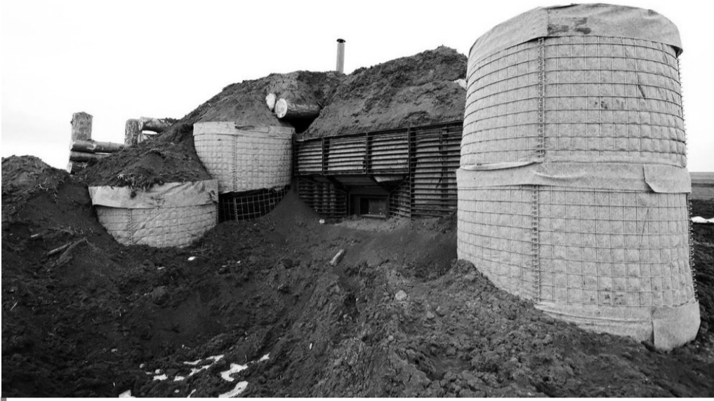
Будівництво під обстрілами окупантів: на Харківщині триває зведення фортифікацій.
